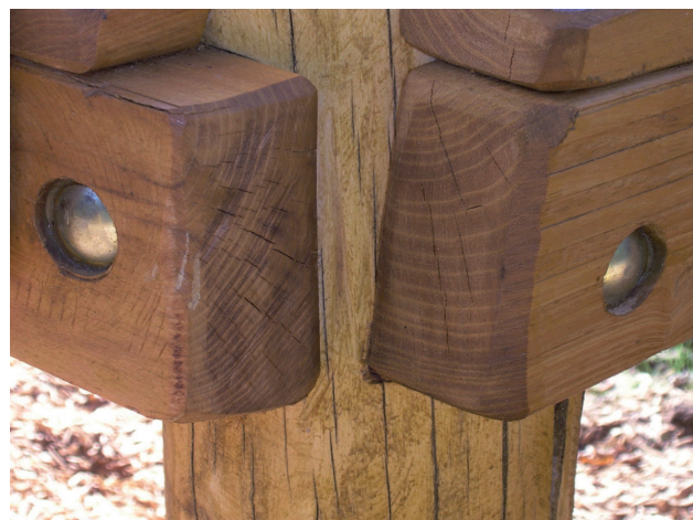
Handwerklich konstruktiver Holzschutz: Die Lage der Hölzer – Kernseite nach oben, so dass die radialen Schwind-/Trockenrisse schräg nach unten verlaufen und keine Wassertaschen bilden können.
