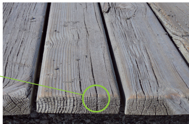
Patina der Kiefern KDI-Bretter nach 5 Jahren Wind-, Wasser- und Seeluft hat keinen Einfluss auf die Festigkeit.
